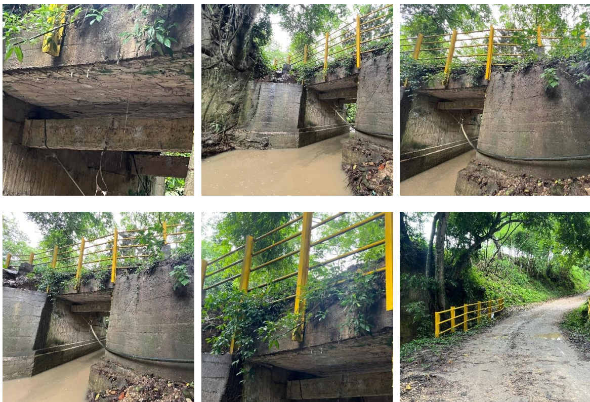
Figuras No 8-13. Estado Actual de la estructura
